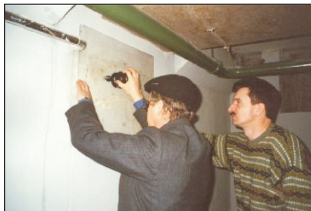
Операторы с прибором "РАСКАН-4" во время обследования стены
