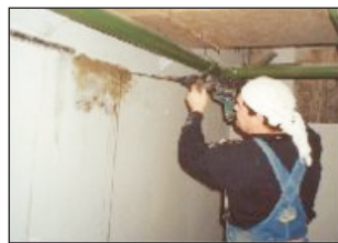
Заделка протечки гидроизолирующим раствором
